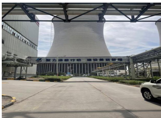
图 3-9 走访调研华电新疆发电有限公司及所属发电厂现场
