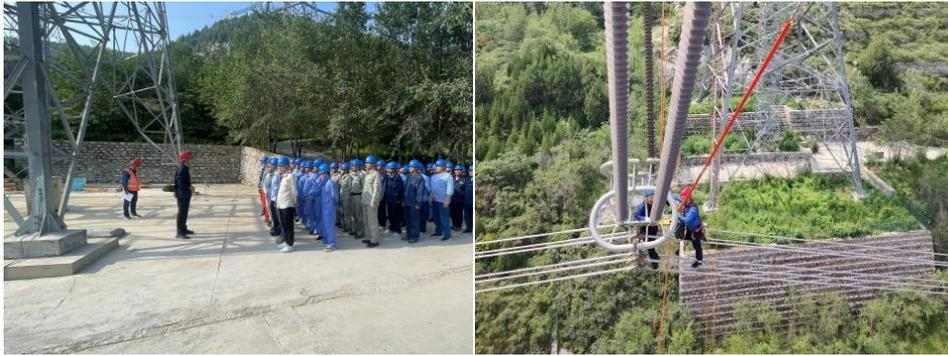
图 2-4 特高压直流输电线路带电作业取复证培训
