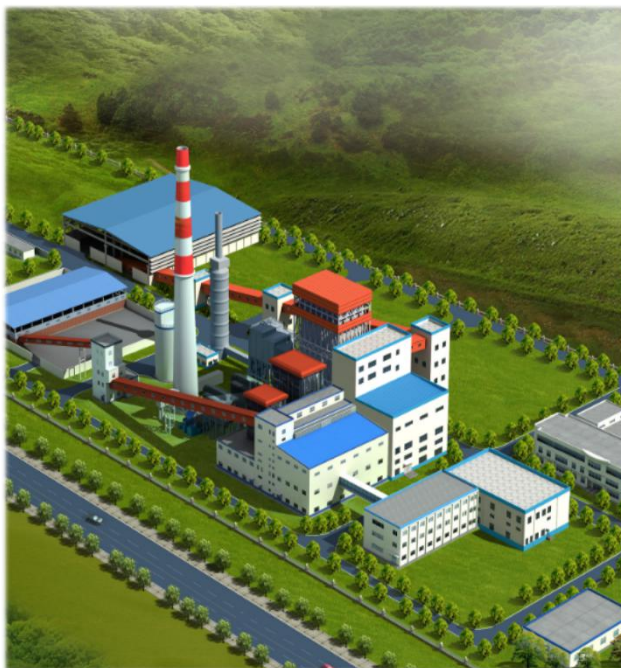
威海市文登热电厂开发区热电工程 1×170t/h CFB Boiler+1×B15MW
