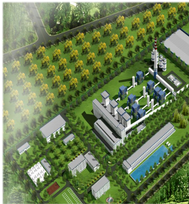
临沂阳光热力有限公司西部供热中心项目 2×130t/h + 2×260t/h CFB Boiler+1×B30MW
