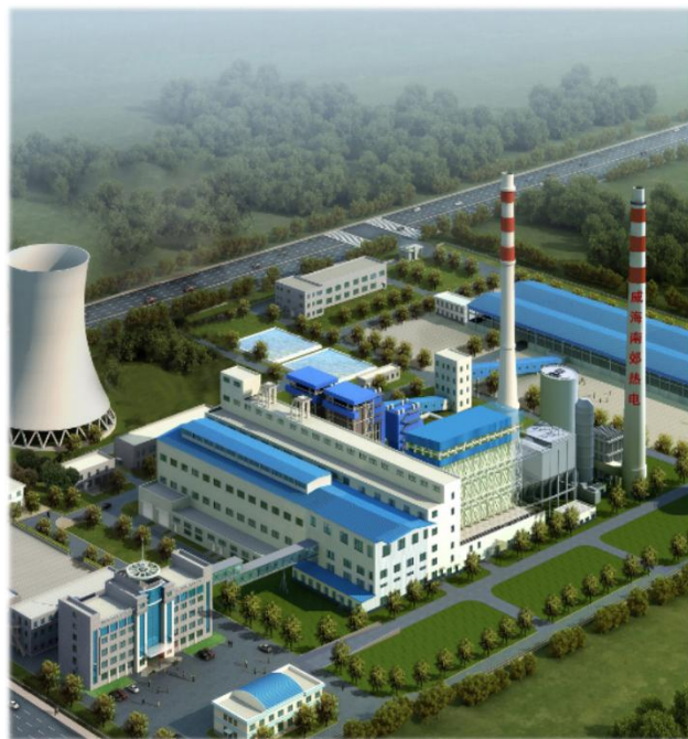
威海市南郊热电有限公司3#锅炉扩建工程 1×260t/h CFB Boiler+1×B30MW
