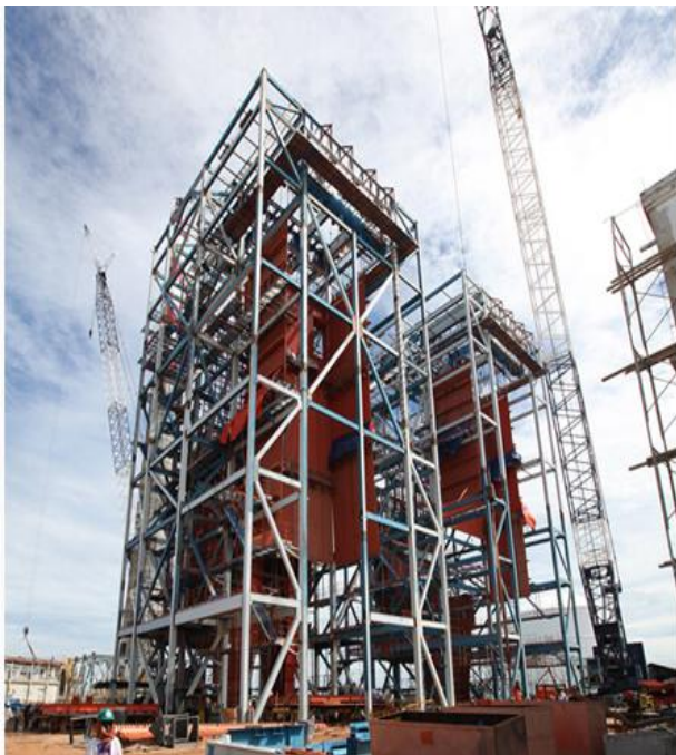
印尼PLN项目NTT纯凝发电项目 2×750t/h CFB Boiler+2×16.5MW
