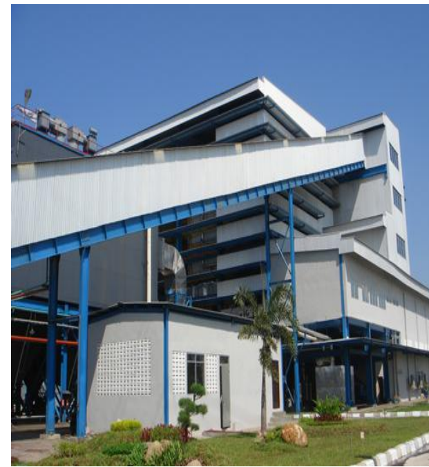
印尼IPP项目 LOMBOK纯凝发电厂 2×138t/h CFB Boiler+2×33MW
