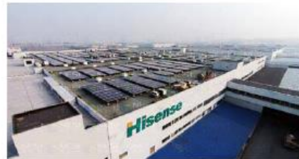
海信15MW光伏发电示范项目
