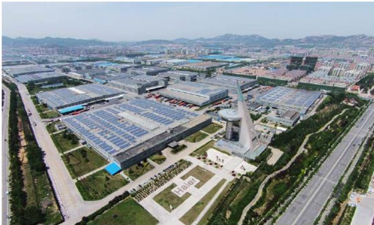
海尔30MW金太阳光伏示范项目
